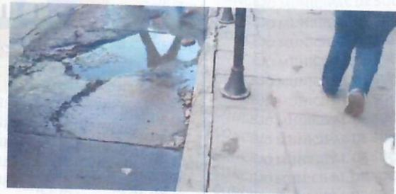
2. Reemplazar las losetas de piedra que se encuentran con grietas, fisuras, desprendidas y garantice el uso de las aceras para circulación peatonal.
