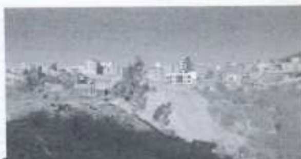
RELLENO DE QUEBRADA
