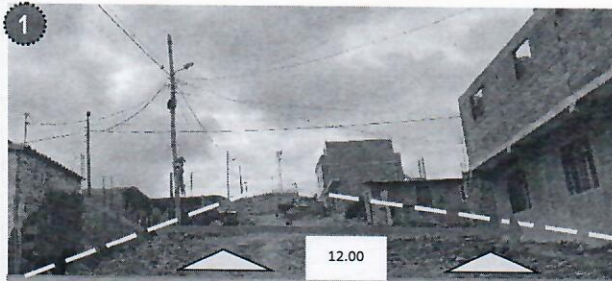
Vía Colectora (sin denominación) consolidada de tierra con un ancho aproximado de 12.00 m. Tomando en cuenta la georreferenciación del PROYECTO DE REGULARIZACIÓN TÉCNICA DE ASENTAMIENTOS HUMANOS IRREGULARES BARRIO "LOS ÁNGELES 2" (vía a registrar a favor del G.A.M.S.)
