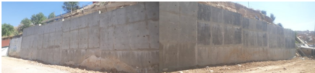
Inspección al Muro de Contención "Alto Delicias"
