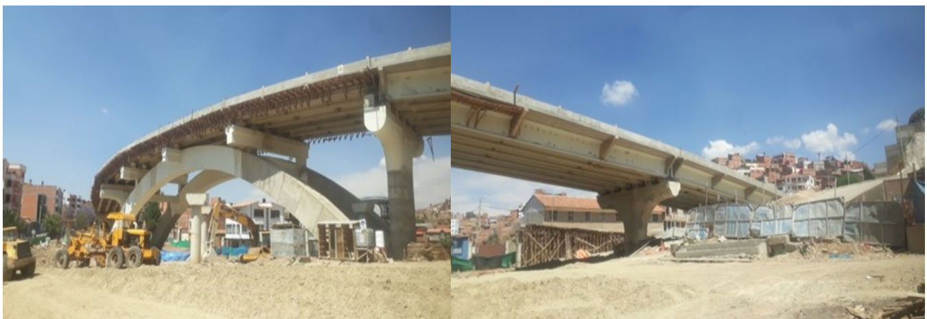
INSPECCIÓN AL DISTRIBUIDOR VIAL DE TINTAMAYU
